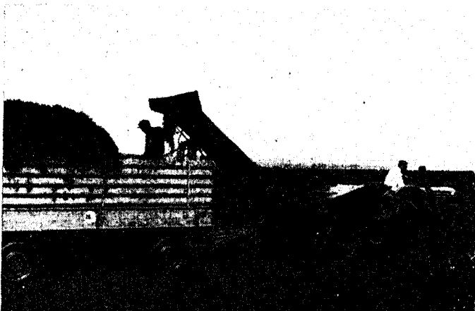
Abb. 7: Eine Zusatzeinrichtung für das Laden von Naßgütern ist dieser Grüngutelevator hinter einer Aufsammelniederdruckpresse. Auf dem Wagen muß schwere Handarbeit geleistet werden
